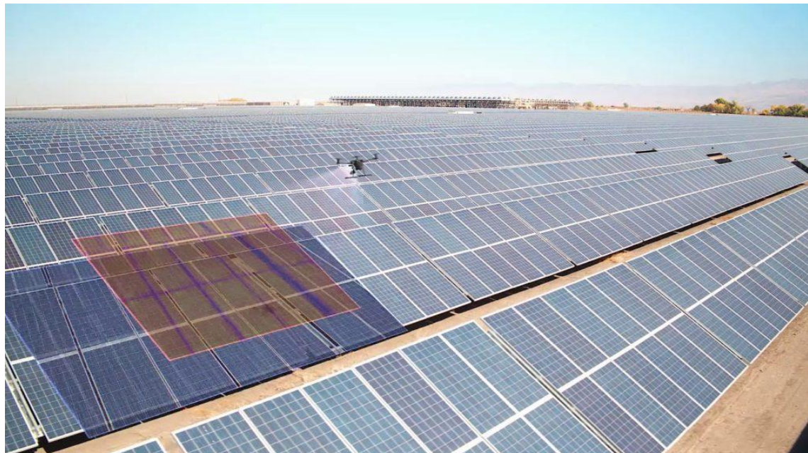
Рисунок 2 – Визначення пошкоджених ФЕМ за допомогою квадрокоптеру
